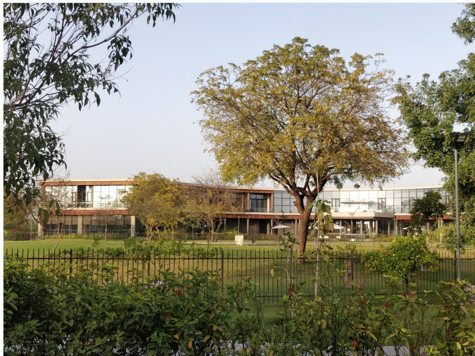
Actual Site Image
