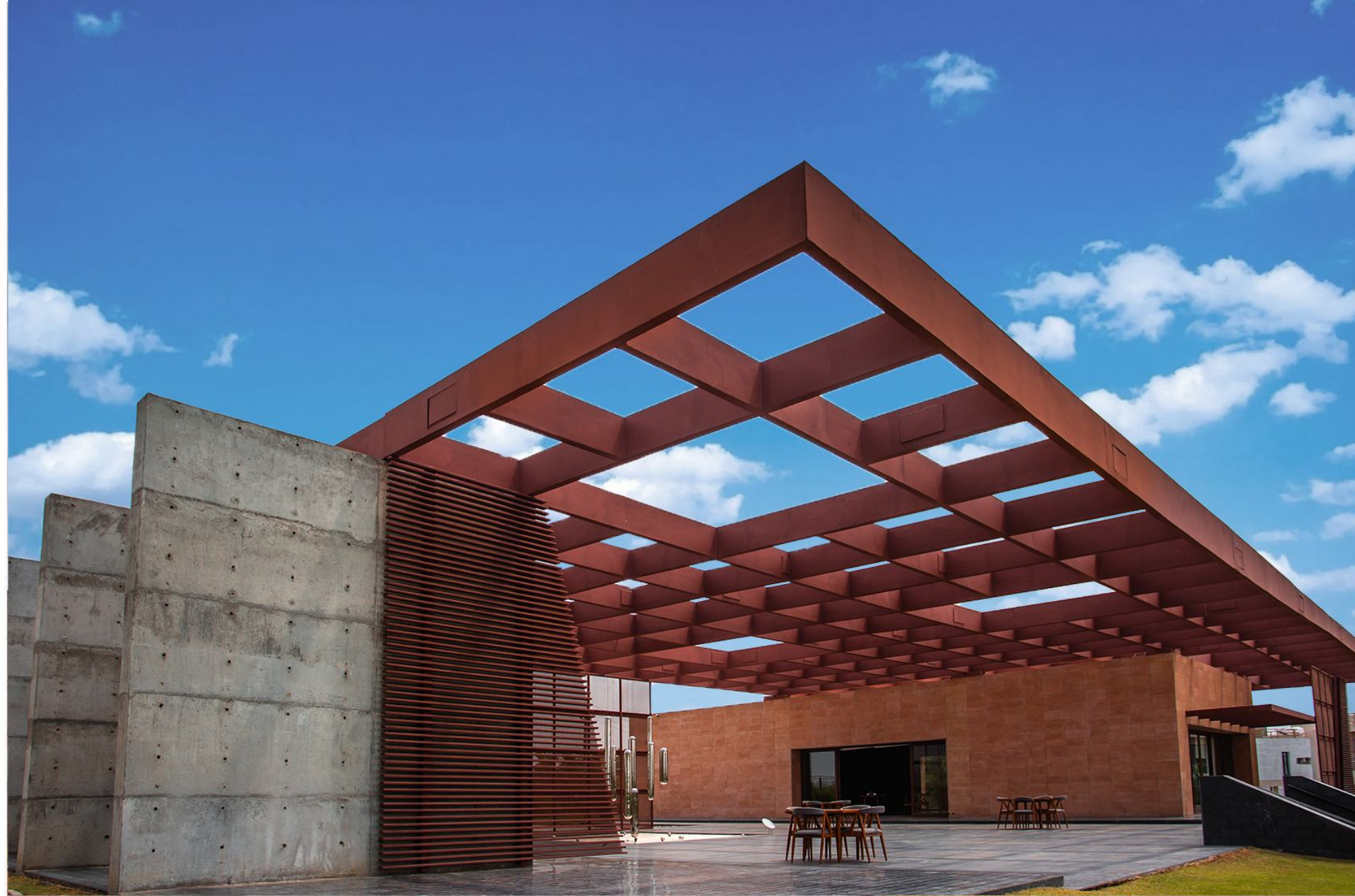
Actual Site Image
