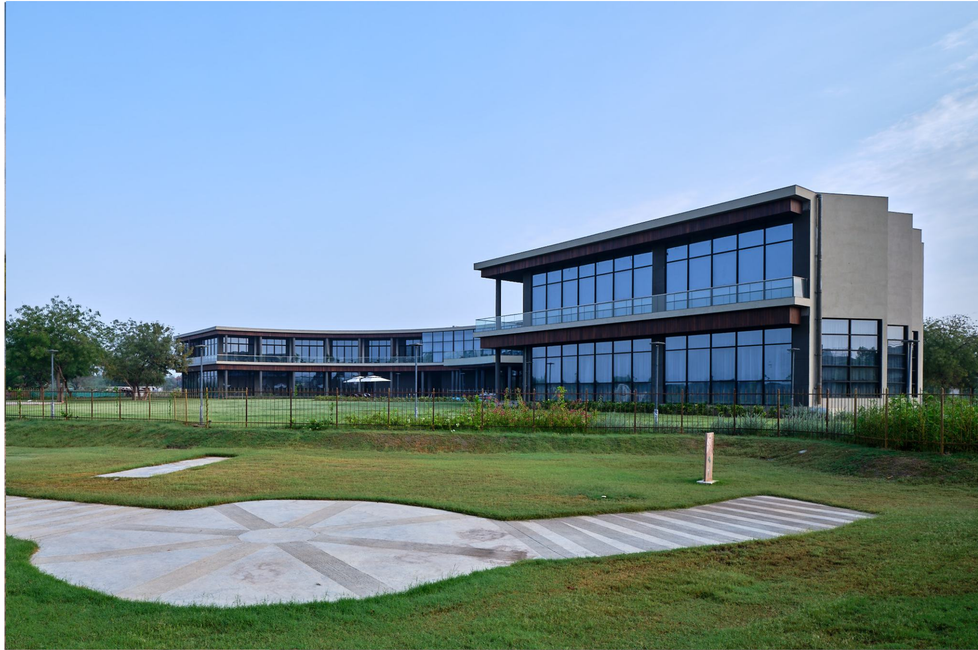
Actual Site Image
