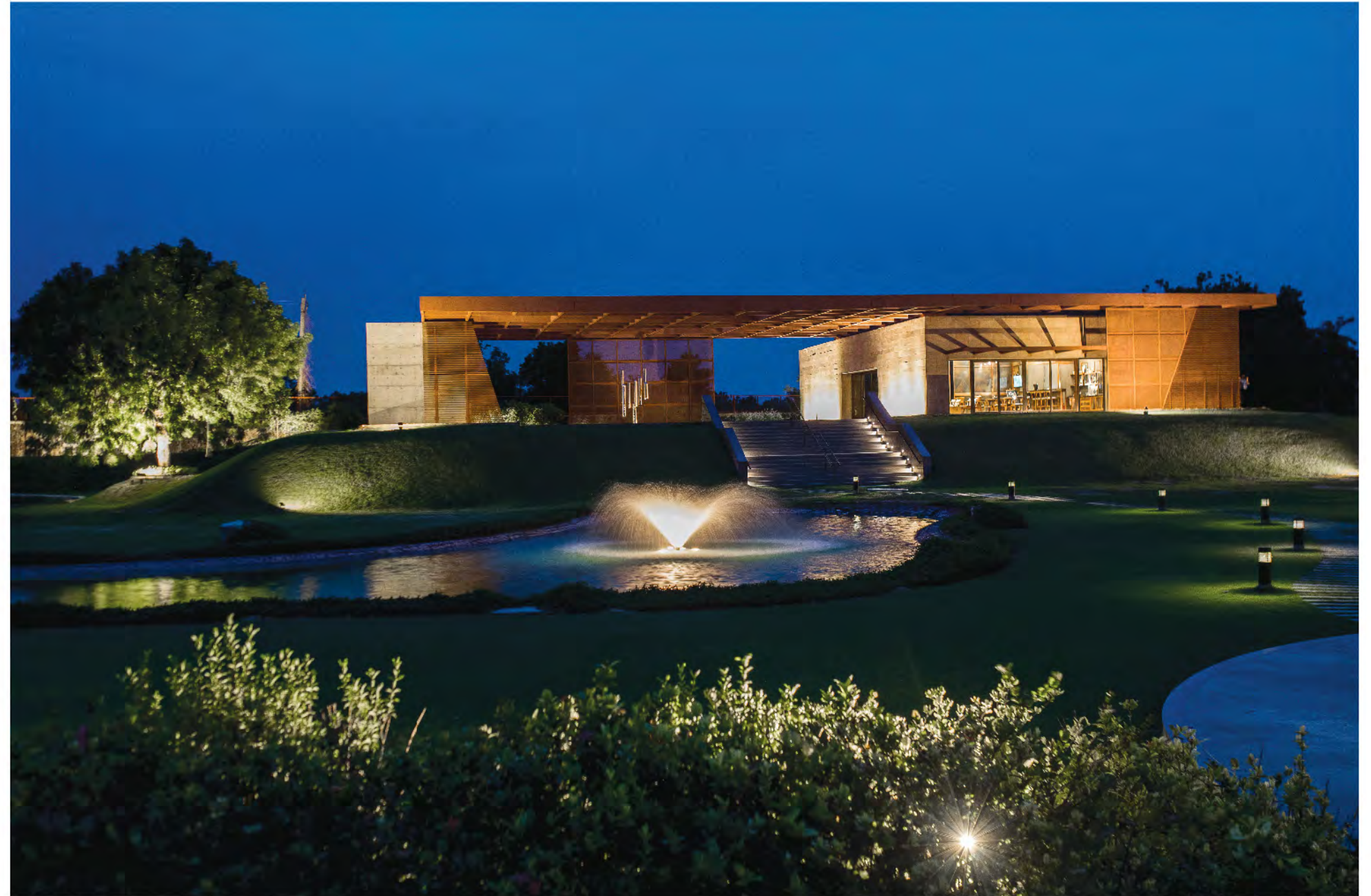
Actual Site Image
